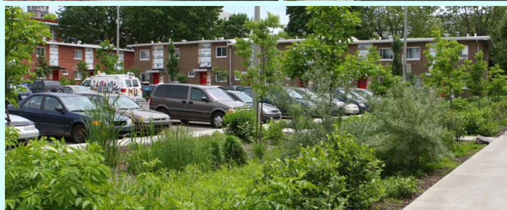
Noues végétalisées et parking perméable pour une gestion des eaux pluviales intégrées
