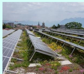
Panneaux solaires et toiture terrasse végétalisée sur bâti d'activités
