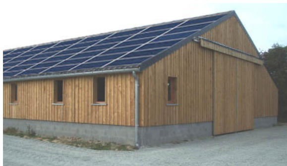
Image 1 : implantation de capteurs sur 100% de la couverture
