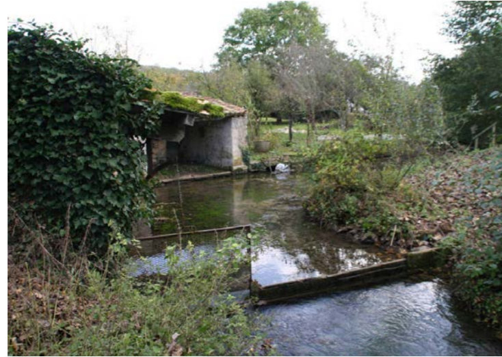
Lavoir abandonné et lavoir restauré
