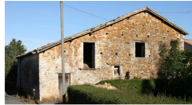
Protection dans le prolongement de la toiture au Nord
