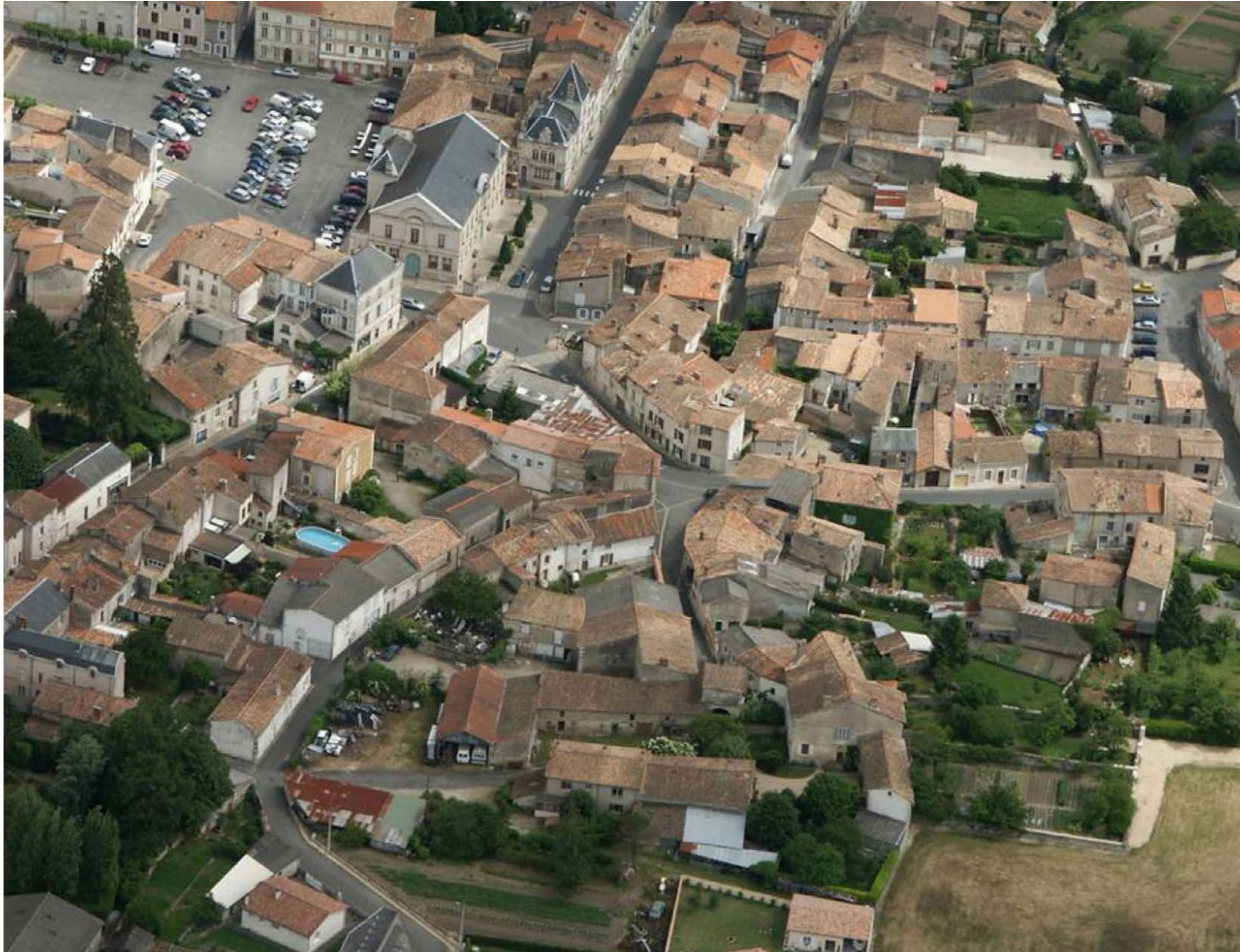
Le premier bourg et château supposé situé à l'emplacement de l'actuelle mairie
