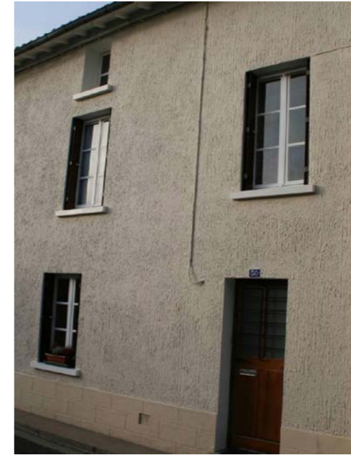
Bâtiment de qualité à réhabiliter
