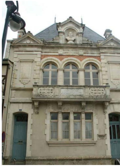
Bâtiment remarquable en bon état
