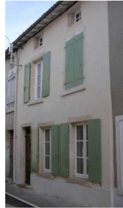
Bâtiment de qualité en bon état
