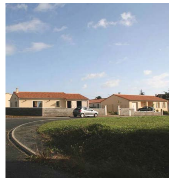
Lotissement du Barrabas : maisons isolées et entourées de murs
