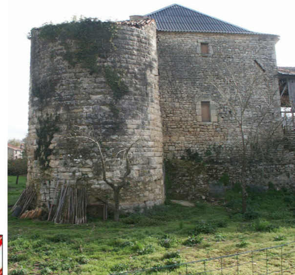
Vestiges des communs du château
