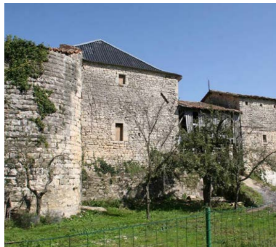
Vestiges des communs du château
